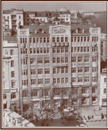
Київ, вул. Хрещатик, 6. Конторська будівля.
